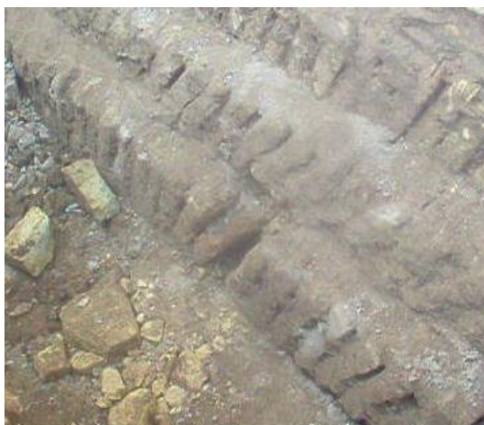
Рисунок 12. Кирпичи, уложенные в форме "ёлочки" в памятнике "Тошхавли саройи" и фундаменте мечети Хасан Мурод кушбеги (г. Хива, Ичан Кала)
