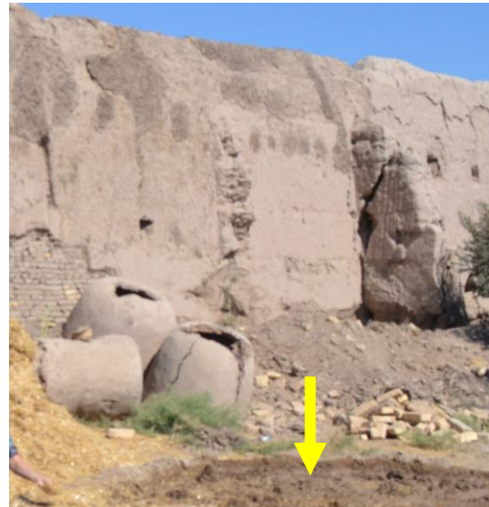
14-расм. Ичан Қалъа пахса деворини ва “Улли Ҳовли” обидасини таъмирлаш учун “сомон-лой” тайёрлаш жараёни
