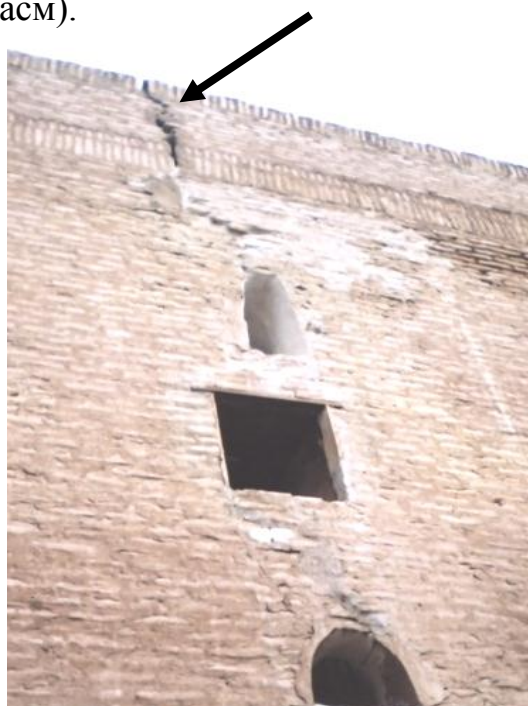
27-расм. Қутлуғ Мурод иноқ мадрасасининг авария ҳолатидаги гулдаста минораси ва пойдевор чўкишидан деворда пайдо бўлган ёриқлар
