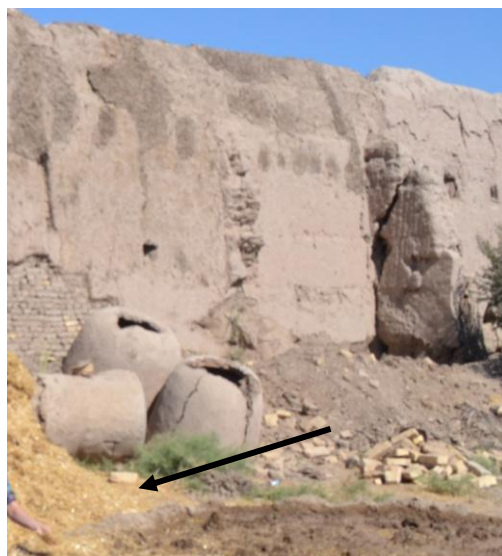
Рисунок 14. Процесс изготовления "сомон-лой" для реконструкции глинобитной стены крепости Ичан Кала и памятника "Улли Ховли"
