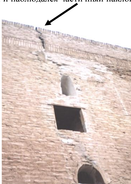
Рисунок 27. Аварийный гульдаста-минарет медресе Кутлуг Мурад инака и трещины, появившиеся на стене после осадки фундамента
