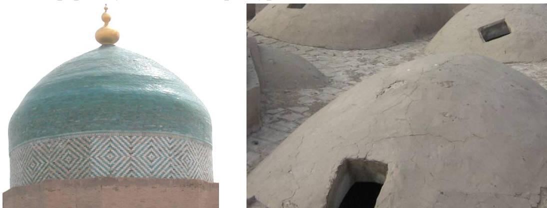
9-расм. Паҳлавон Маҳмуд мажмуасининг хонақо қисмидаги тик гумбаз ва Сферик гумбаз шакллари
