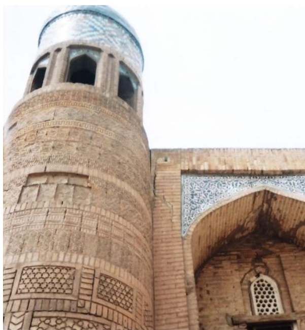
Рисунок 27. Аварийный гульдаста-минарет медресе Кутлуг Мурад инака и трещины, появившиеся на стене после осадки фундамента
