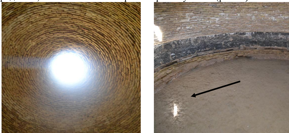
Рисунок 18. Процесс изучения фундамента наземной купольной части и внутреннего колодца медресе Кутлуг Мурод инок
