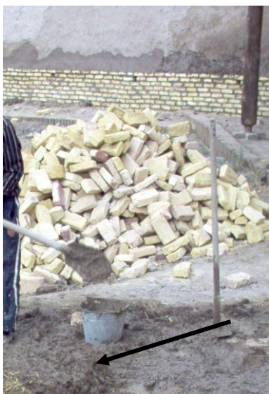
Рисунок 14. Процесс изготовления "сомон-лой" для реконструкции глинобитной стены крепости Ичан Кала и памятника "Улли Ховли"
