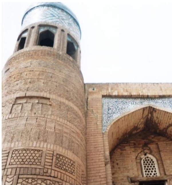
27-расм. Қутлуғ Мурод иноқ мадрасасининг авария ҳолатидаги гулдаста минораси ва пойдевор чўкишидан деворда пайдо бўлган ёриқлар
