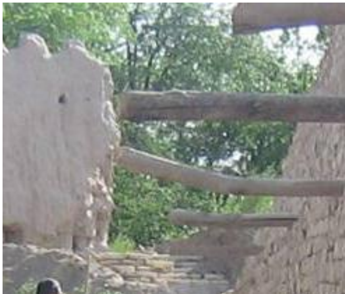
15-расм. Дешон-Қалъа ёдгорлигининг деворида ёғочларнинг ишлатилиши
