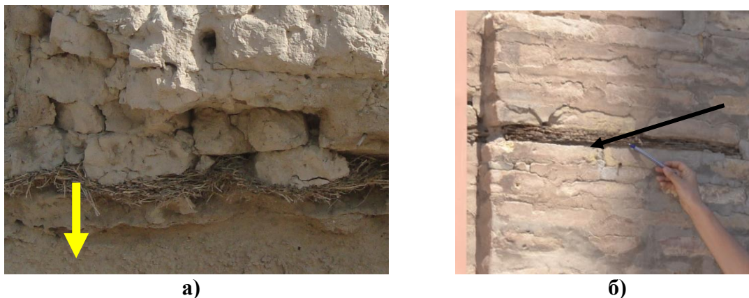
6-расм. Эрамиздан олдинги VI асрга оид “Қат қалъа” пахса деворининг пастки, цоколь қисмига ётқизилган сейсмоизоляция қамиш қатлами 1 қатор (а); Толиб Махсум мадрасасида эса қамиш қатлами иккита қўйилган, (б) расмда тепа қисмидаги қамиш қатламининг кўриниши;
