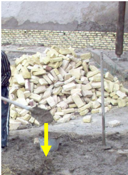
14-расм. Ичан Қалъа пахса деворини ва “Улли Ҳовли” обидасини таъмирлаш учун “сомон-лой” тайёрлаш жараёни
