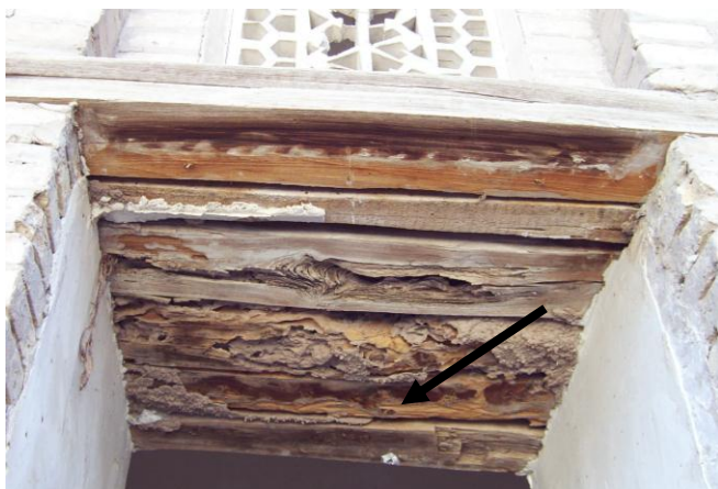
30-расм. Юсуф Ясовулбоши мадрасаси эшик тепаси ёғочларининг термитдан зарарланиши ва термитнинг кўриниши
