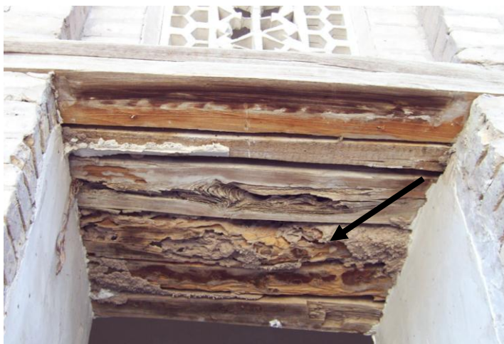
Рисунок 30. Повреждение древесины на верхней части входа в медресе Юсуфа Ясовулбоши и вид термитов
