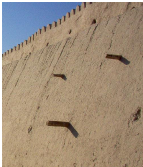
15-расм. Дешон-Қалъа ёдгорлигининг деворида ёғочларнинг ишлатилиши
