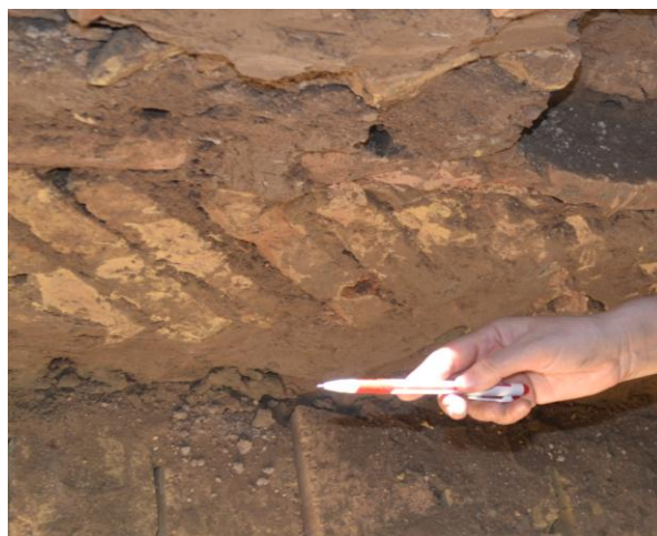
Рисунок 12. Кирпичи, уложенные в форме "ёлочки" в памятнике "Тошхавли саройи" и фундаменте мечети Хасан Мурод кушбеги (г. Хива, Ичан Кала)
