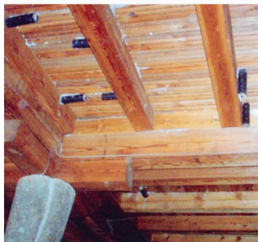
Рисунок 31. «Кормы-приманки» на поврежденных термитами древесных колоннах архитектурного памятника Джума Мечети
